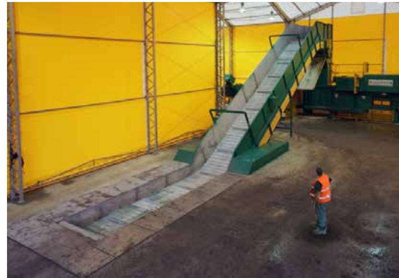
UNTERFLUR-LADEBEREICH (MIT VERTIEFTEM SCHACHT)
